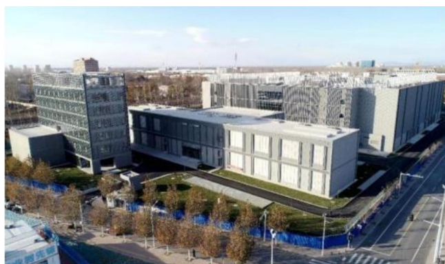
图3：光环新网天津宝坻数据中心
