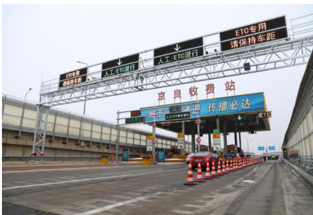
图15: 高速公路新型智慧收费系统
