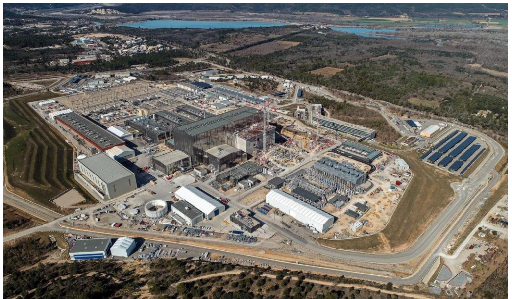
图9: ITER 科学装置建设工地
