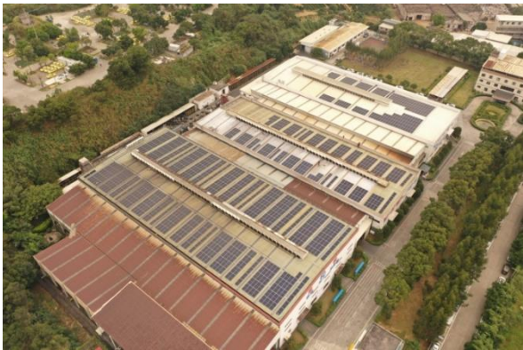
图 5：隆基福建福州金锻 700kW 工商业发电项目 (Hi-MO 6 Max 极智家)
