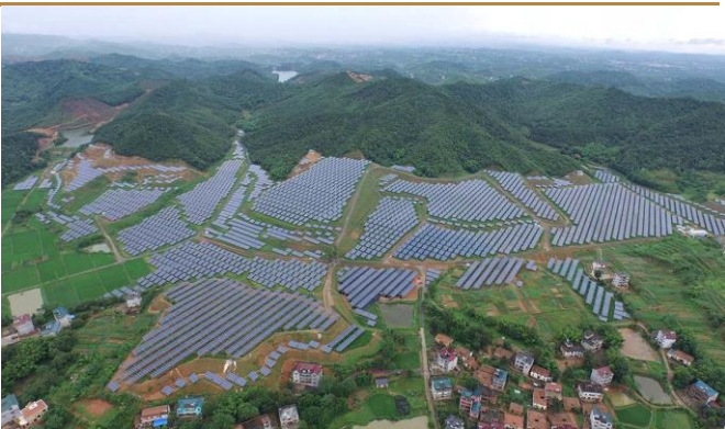
图：凤林 30MWP 农林光互补智能光伏电站
