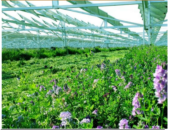
图：宝丰 350MWP 斜单轴跟踪系统
