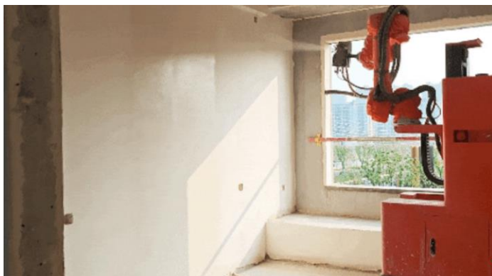
图表8：喷涂机器人（内墙乳胶漆）
