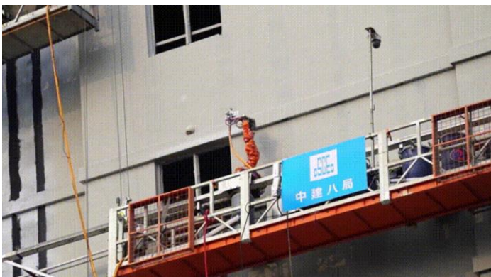
图表9：喷涂机器人（外墙真石漆）
