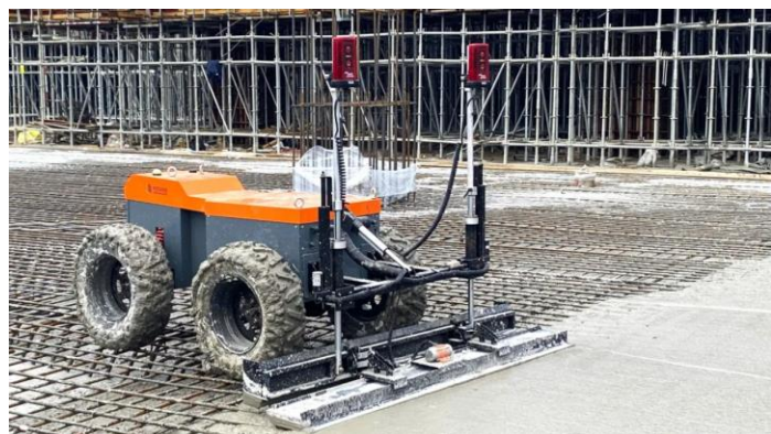
图表5：整平机器人
