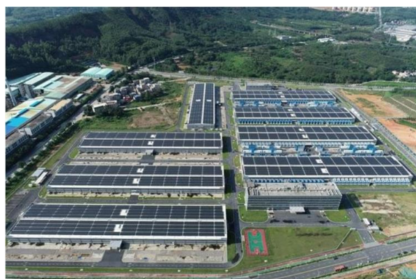
图6：腾讯天津高新云数据中心分布式新能源微电网示范项目
