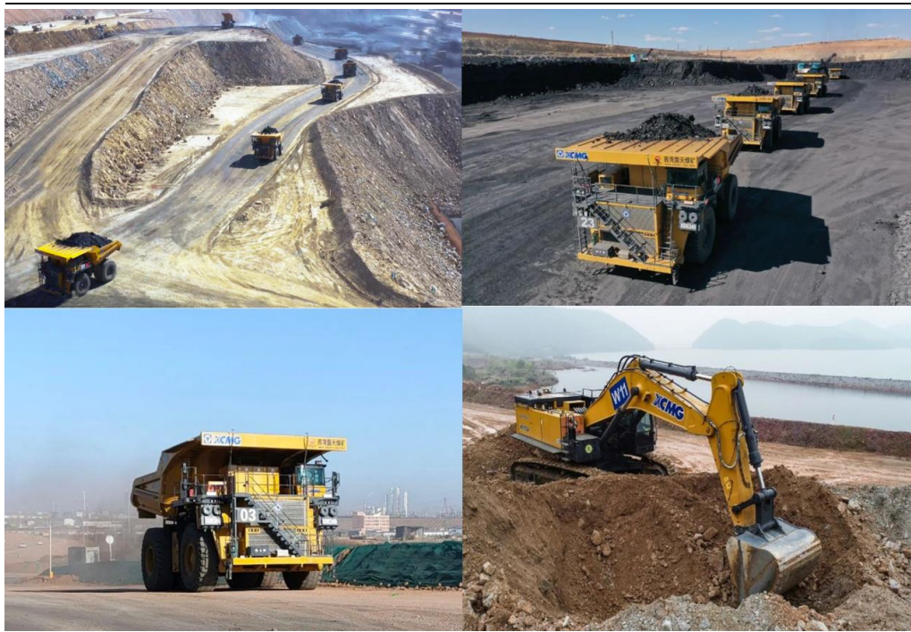
图46：公司无人驾驶技术在工地施工
