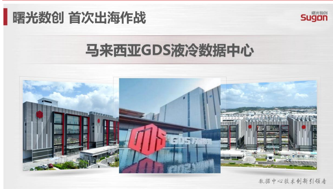
图 30：曙光数创中标马来西亚数据中心项目
