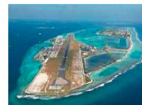
马尔代夫维拉纳国际机场 马尔代夫维拉纳国际机场改扩建项目 助航灯光及导航工程
