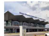
赞比亚恩多拉国际机场 赞比亚恩多拉国际机场目视助航灯 光工程、空管工程、供电工程及弱 电工程
