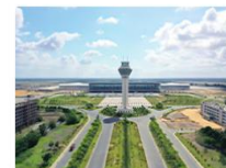
安哥拉罗安达新国际机场 安哥拉罗安达新国际机场项目助航 灯光、供电安装及陆侧照明工程
