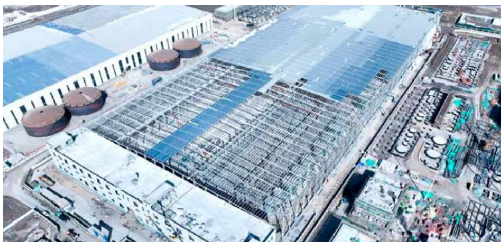
图5：公司4万吨/年基础锂盐一体化项目建设俯瞰图
