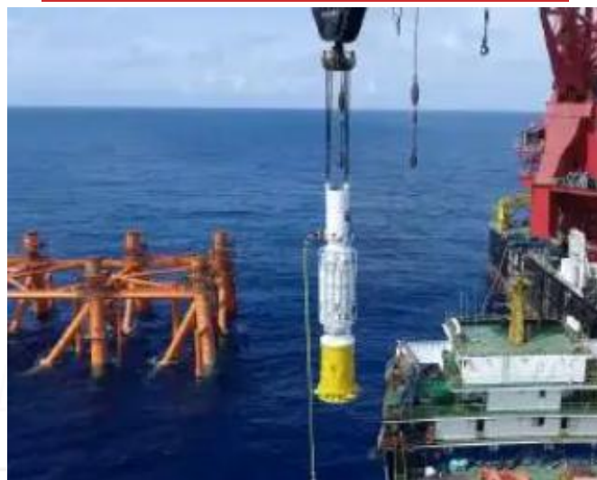
图表16：超深水打桩机
