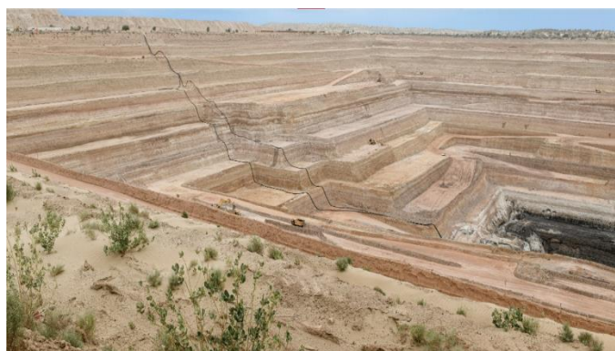
图表24：巴基斯坦塔尔露天煤矿剥离工程（宏大是项目最大的爆破施工承包商）
