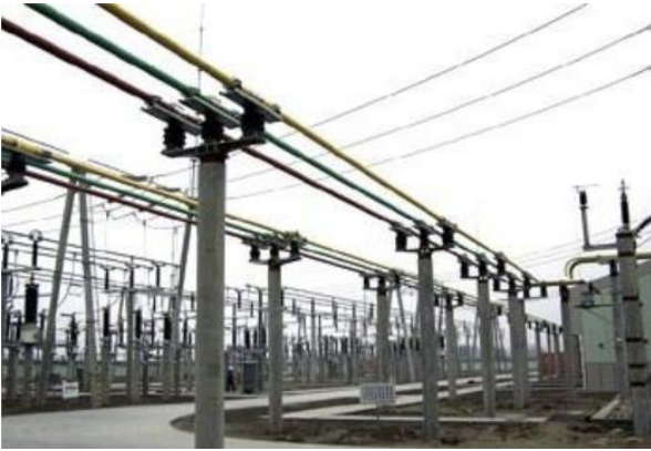
图表14: 电力系统母线
