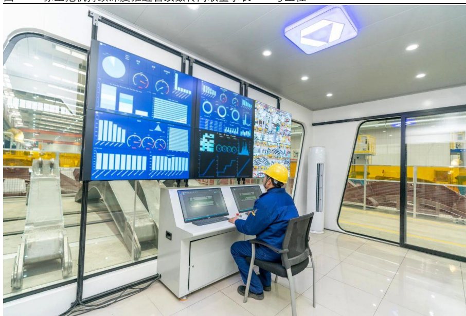
图 47：徐工挖机持续深度推进智改数转网联董事长“一号工程”
