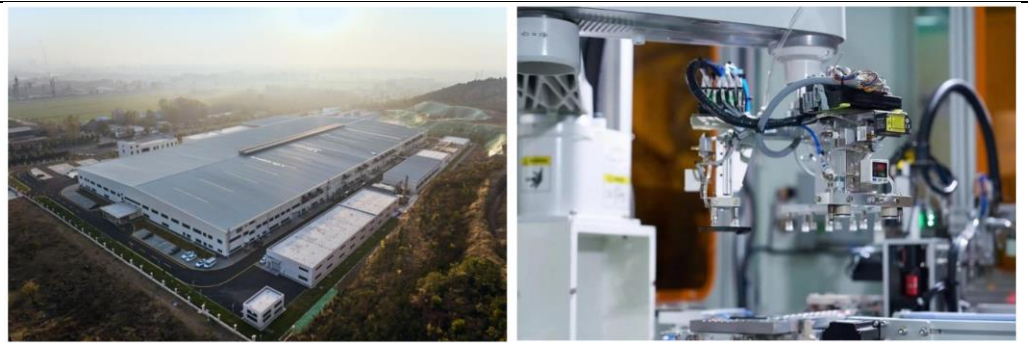
图表 49 奥瑞金枣庄新能源电池结构件生产基地
