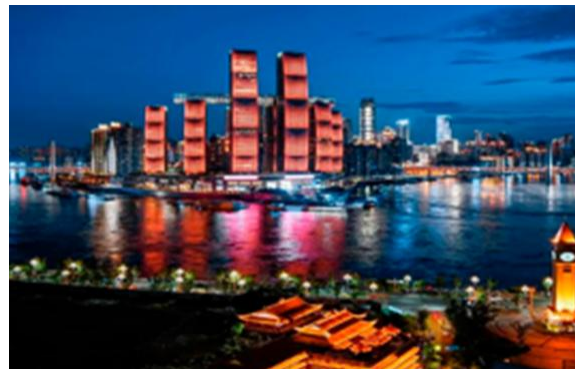
图 29：重庆南岸区城市更新项目工程
