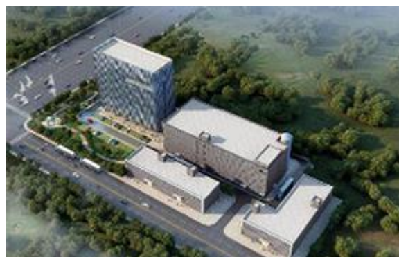
图 21：某国家级经开区新建云数据中心项目（二期）EPC 总承包
