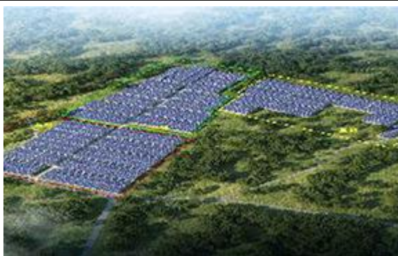
图 25：某省分布式光伏发电 EPC 总承包项目
