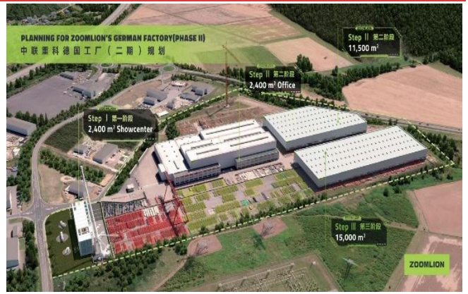
图23：中联重科德国二期工厂项目已奠基
