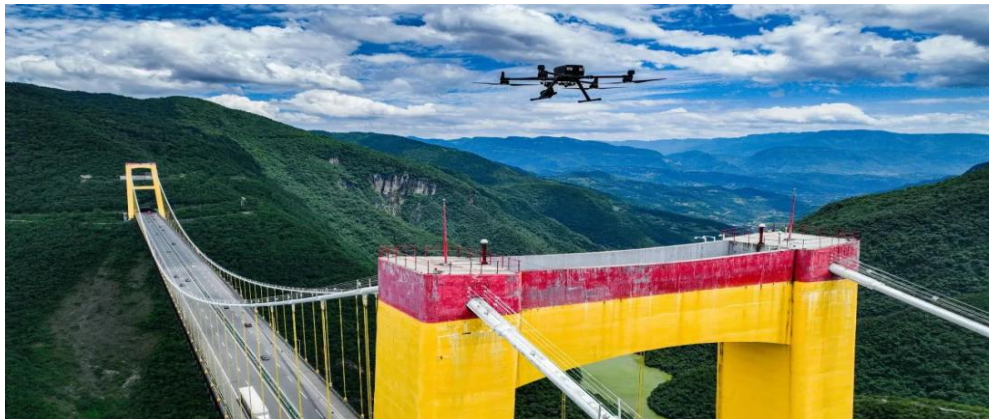
图22：智慧“体检”覆盖养护全领域
