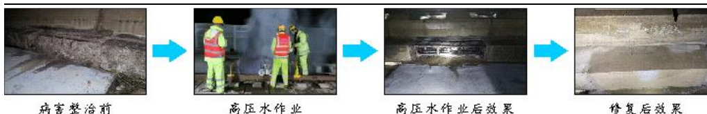
图12：基于超高压低水流的无砟轨道板下劣化混凝土破除技术
