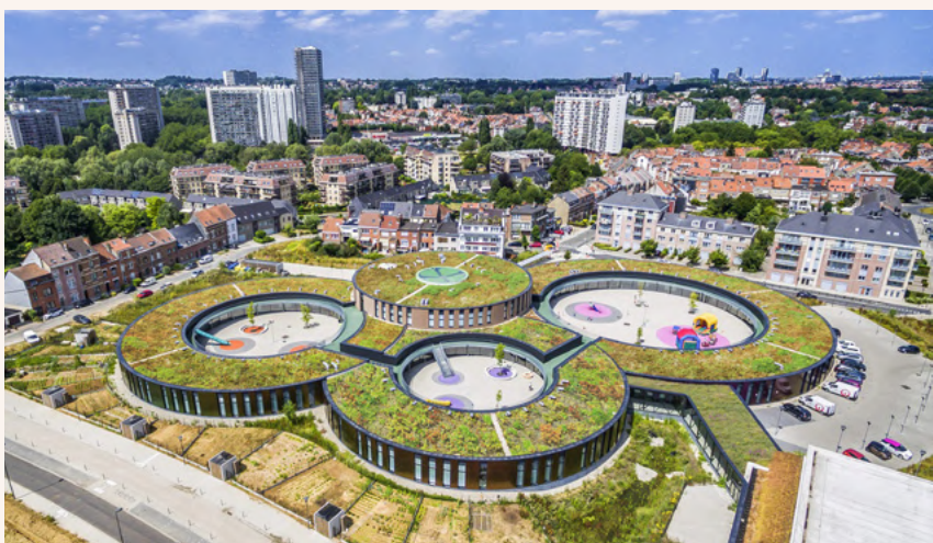
在安德莱赫特的勒·特雷夫勒大楼上提升UltraPly TPO。 布鲁塞尔。© Easycopters
