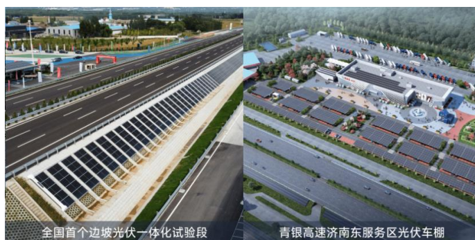
图 32: 山东高速集团部分“高速+光伏”项目 (2)
