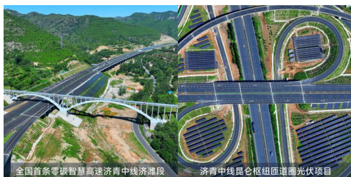
图 31: 山东高速集团部分“高速+光伏”项目 (1)
