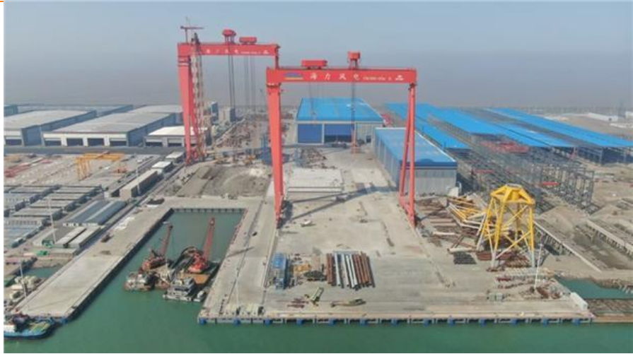
图 21：海力风电启东吕四港码头
