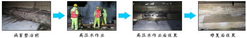
图7：基于超高压低水流的无砟轨道板下劣化混凝土破除技术
