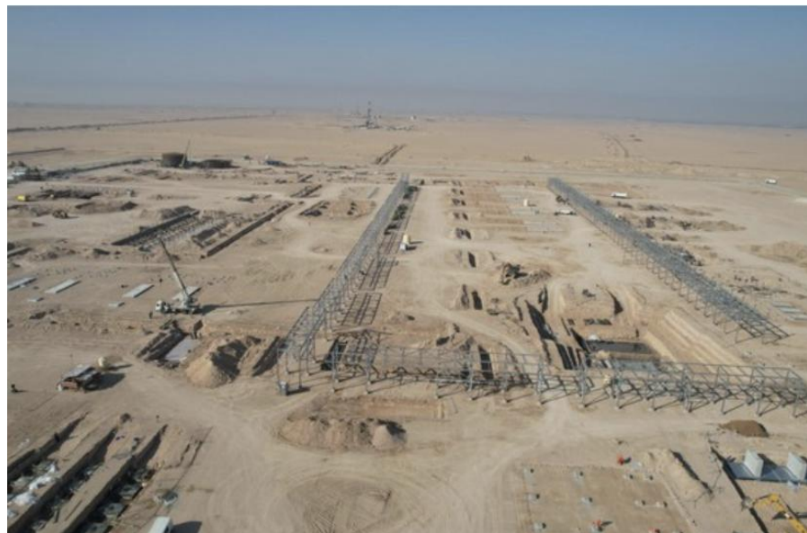
图：JPF-5项目中期现场情况
