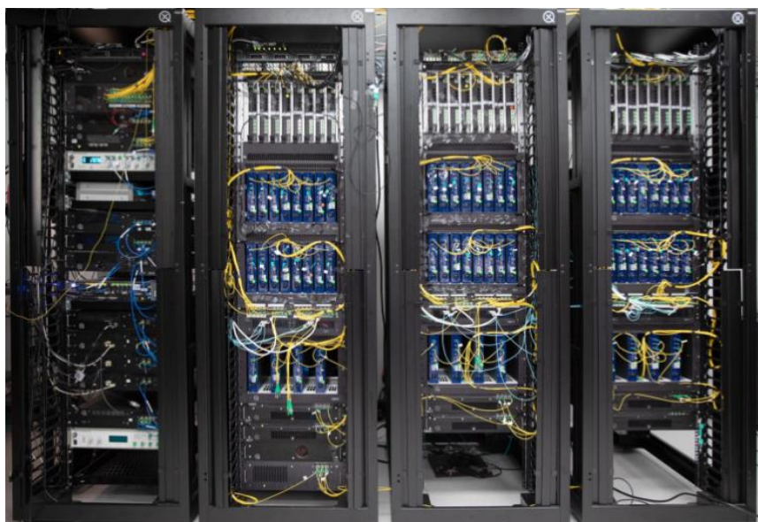
图4：Aurora 的机柜间采用光纤进行连接并支持无限扩展
