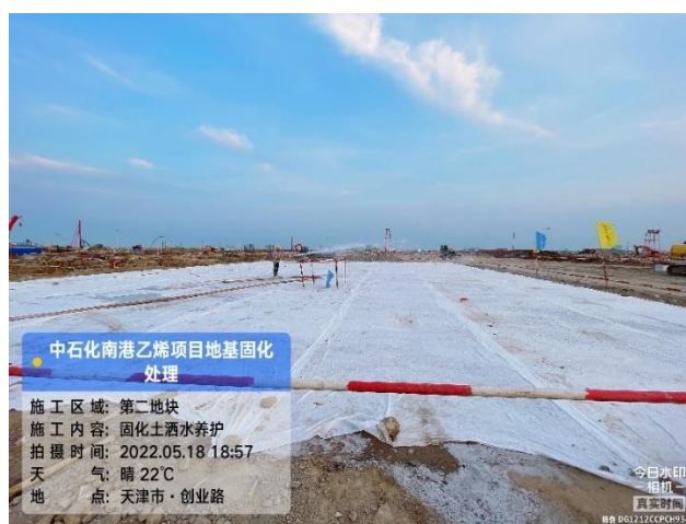
图 23：天津石化南港地基固化处理项目
