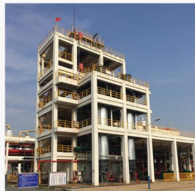
图23:副产蒸汽三合一盐酸合成装置
