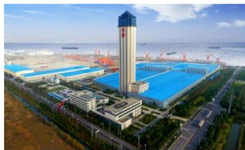
苏州常熟亨通国际海洋产业园
