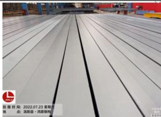
图 19: 喷涂后钢结构表面图
