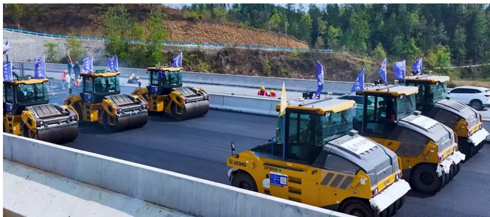
图37、道路施工无人化作业场景
