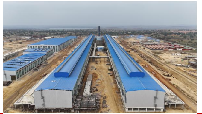
图2：7 月 15 日，电解车间彩板封闭完成
