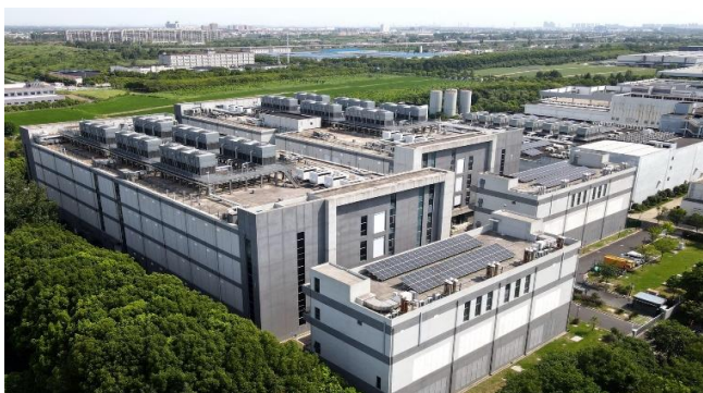
图22：光环新网上海嘉定数据中心
