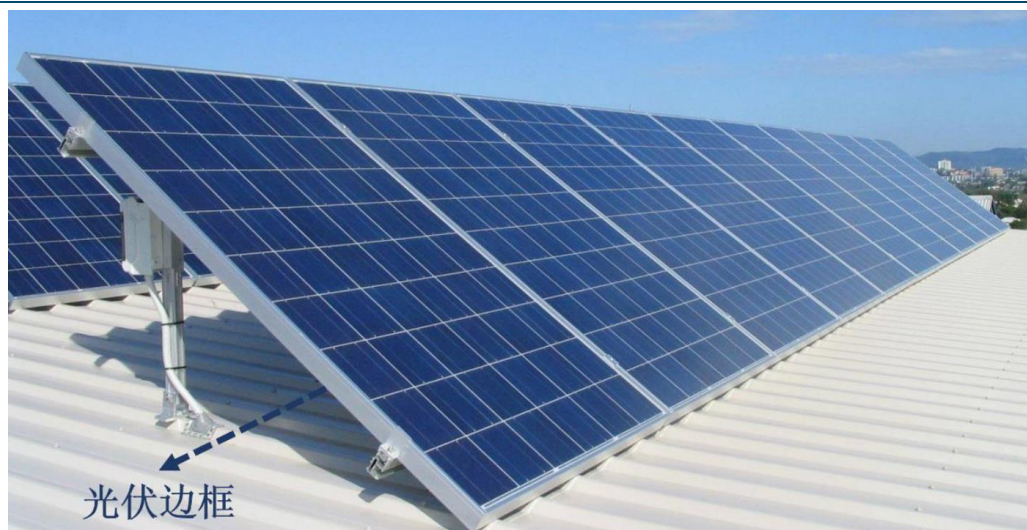
图表19: 边框在光伏组件中起到固定、保护的作用
