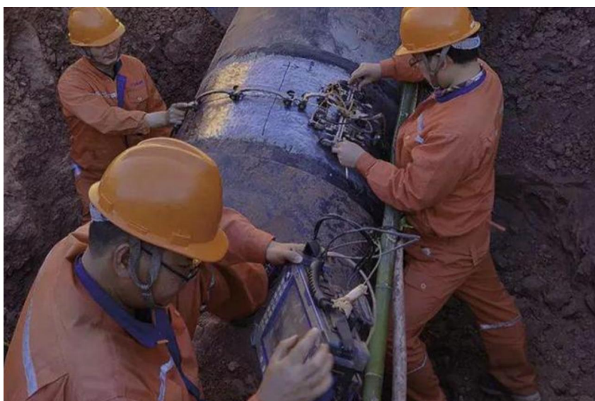
图 14：管道无损检测现场图
