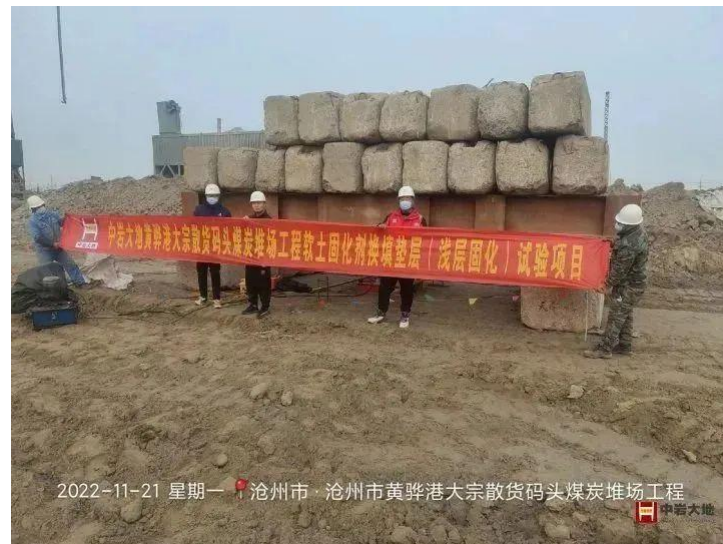
沧州市黄骅港大宗散货码头煤炭堆场工程
