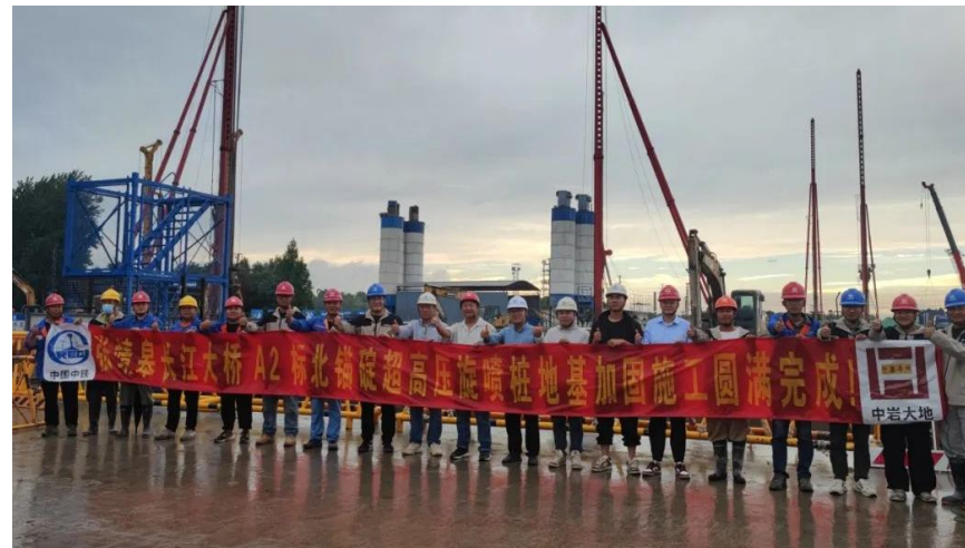
公司完成张靖皋长江大桥A2北锚碇施工
