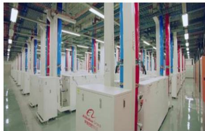
图表6：阿里云单相浸没式液冷服务器集群
