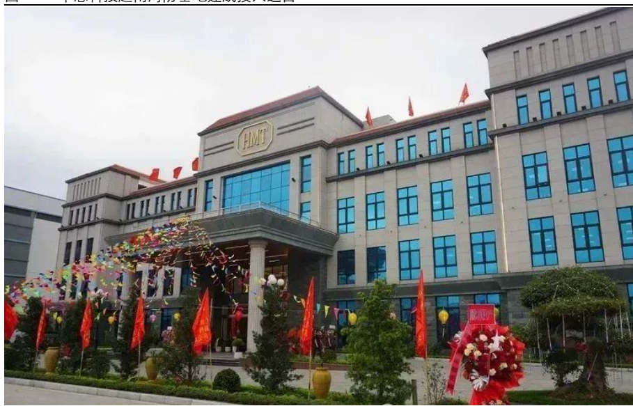
图 17：华懋科技越南海防基地建成投入运营
