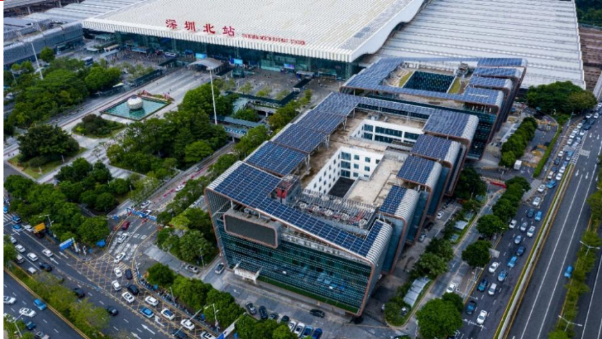
图 5：深圳北站大型综合交通枢纽光储示范项目
