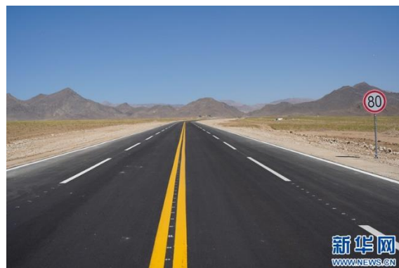
图 13:竣工的进矿道路
