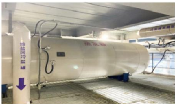
图27: 熔盐储能蒸发器
