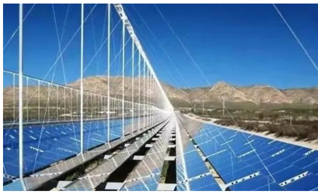
图21: 菲涅尔式光热发电系统
