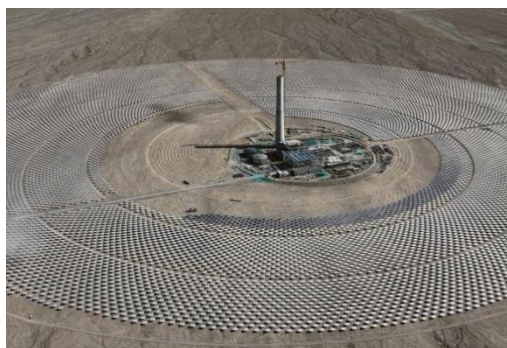
图19: 塔式光热发电系统
