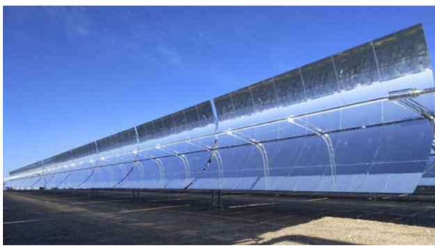
图18: 槽式光热发电系统
