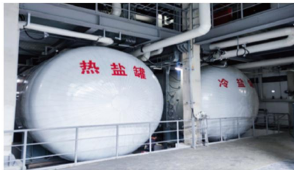
图26: 卧式熔盐储罐
