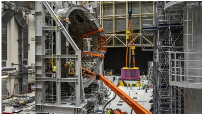
图56 ITER 真空室搭建
