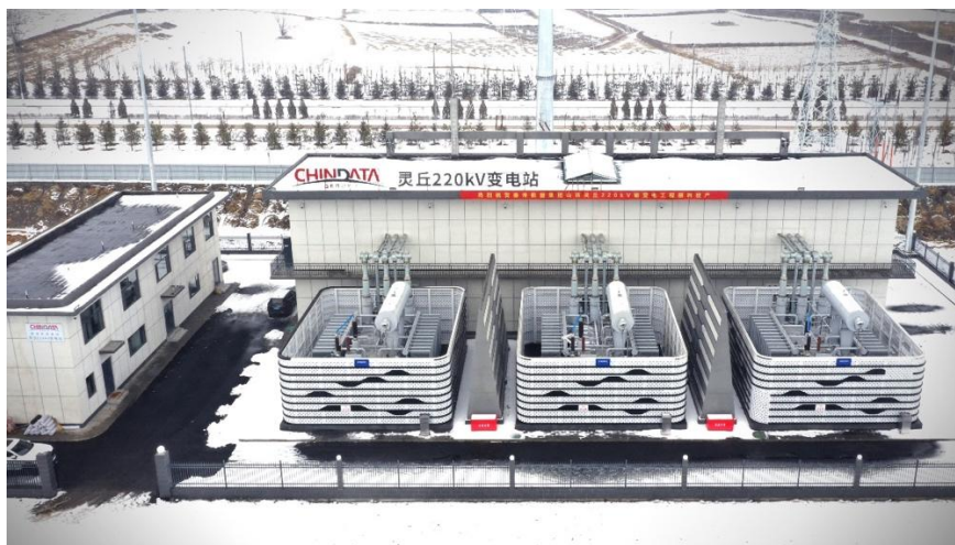
图 45: 秦准数据山西灵丘220kV变电站
