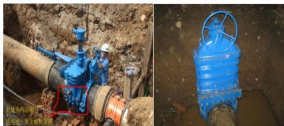
供水管道不停水加装闸门技术施工现场图
