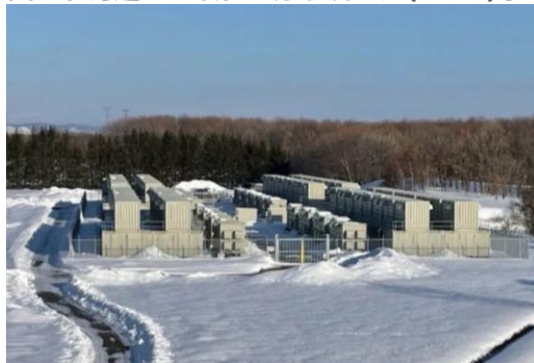
图：北海道全钒氧化还原液流电池(VRFB)系统
