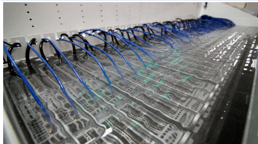
图：数据中心浸没式液冷系统
