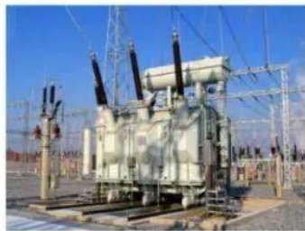
传统配电网中的电力变压器
