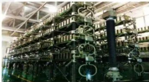
柔性直流输电系统中的电压源型变换器MMC电路结构和实际装置
