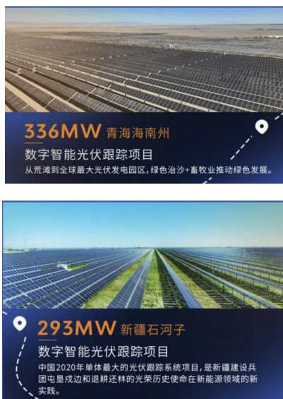
图24：公司跟踪支架部分项目（国内）
