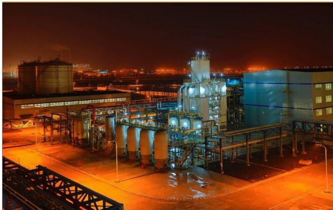
图 35：河北富越化工有限公司 1200000Nm 3 /d 焦炉煤气制氢
