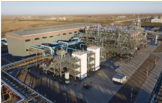
图 21：内蒙古雅海能源年产 60 万吨液化天然气项目
