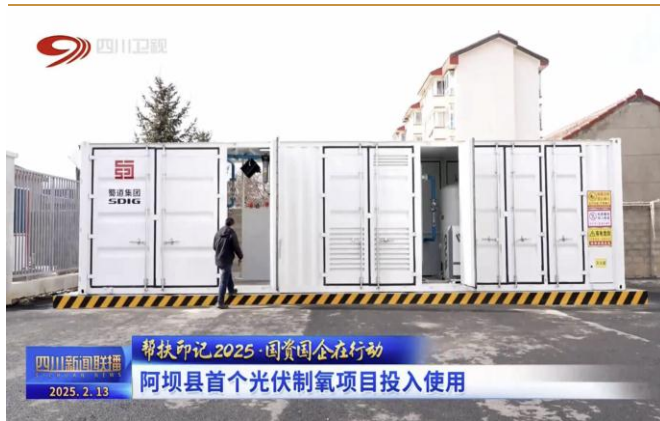
图 49：公司承建阿坝县首个光伏制氧项目
