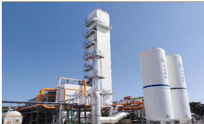
图 24：广东清远联升 6000/14000/200 Nm 3 /h 液体空分装置
