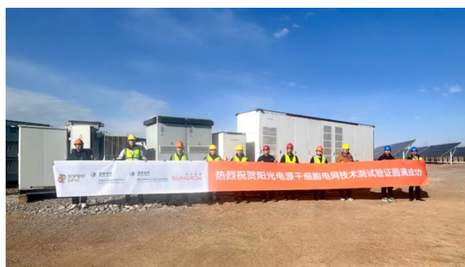
图69：阳光电源完成业内首个光储全场景构网实证
